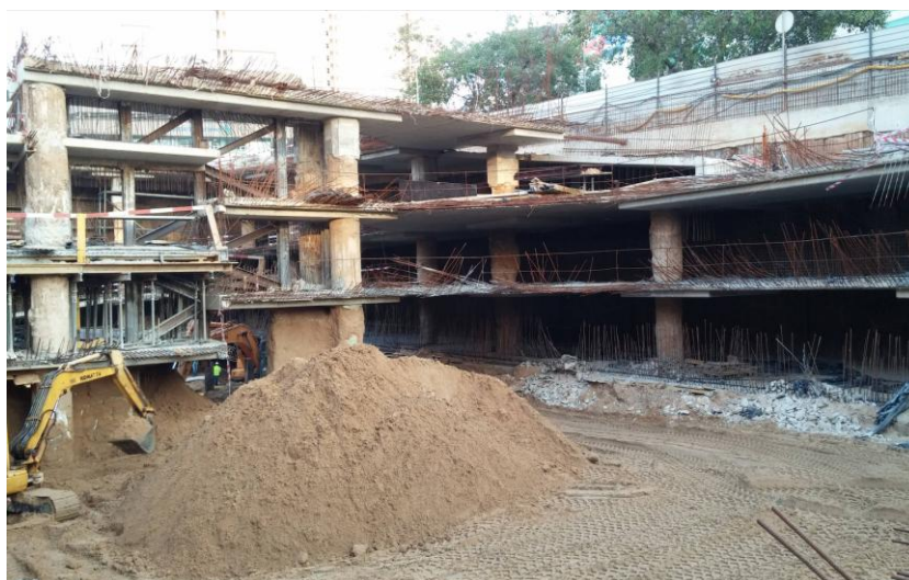
Figura 13 – Fotografia da execução da quarta banda de laje
