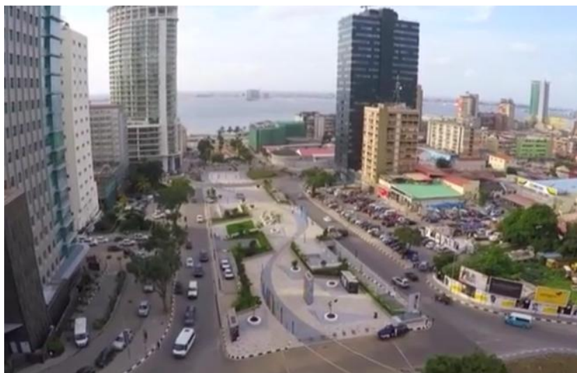
Figura 15 – Aspeto final da obra
