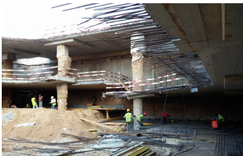
Figura 12 – Fotografia da execução da terceira banda de laje
