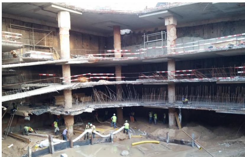
Figura 14 – Fotografia da execução da quinta e última banda de laje
