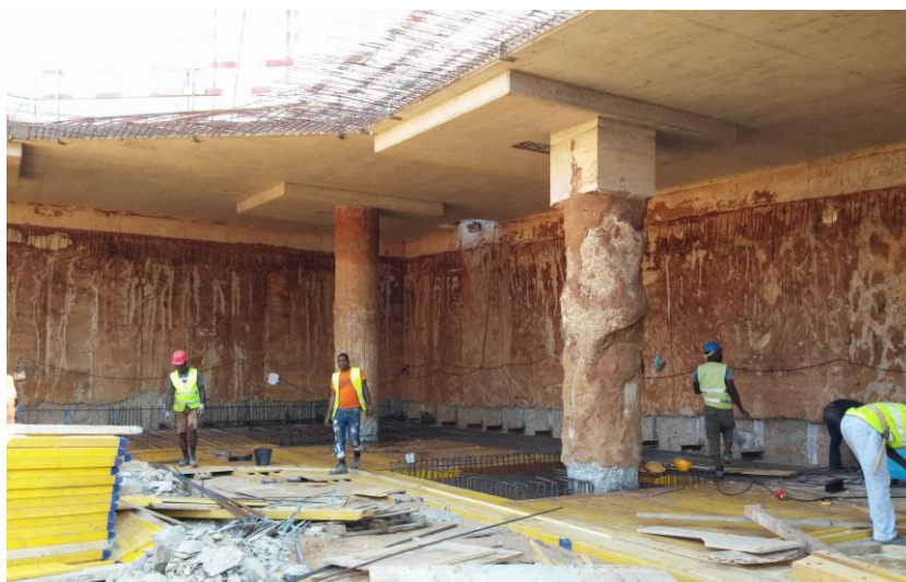
Figura 11 – Fotografia da execução da segunda banda de laje
