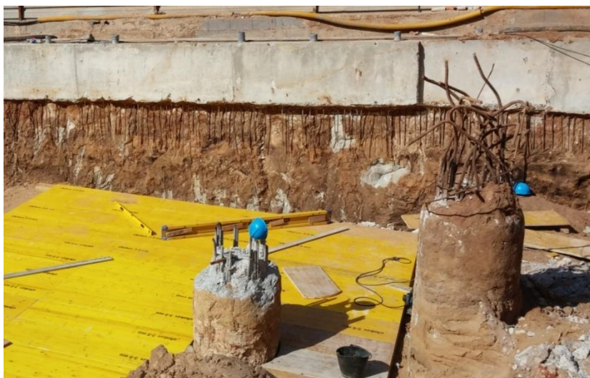
Figura 9 – Fotografia do início da execução da laje de cobertura
