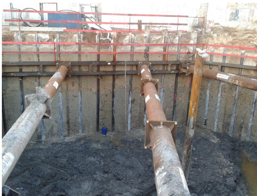
Figura 8 – Fotografia da obra antes da aplicação do segundo nível de escoramento (gentileza da Geo-Rumo)
