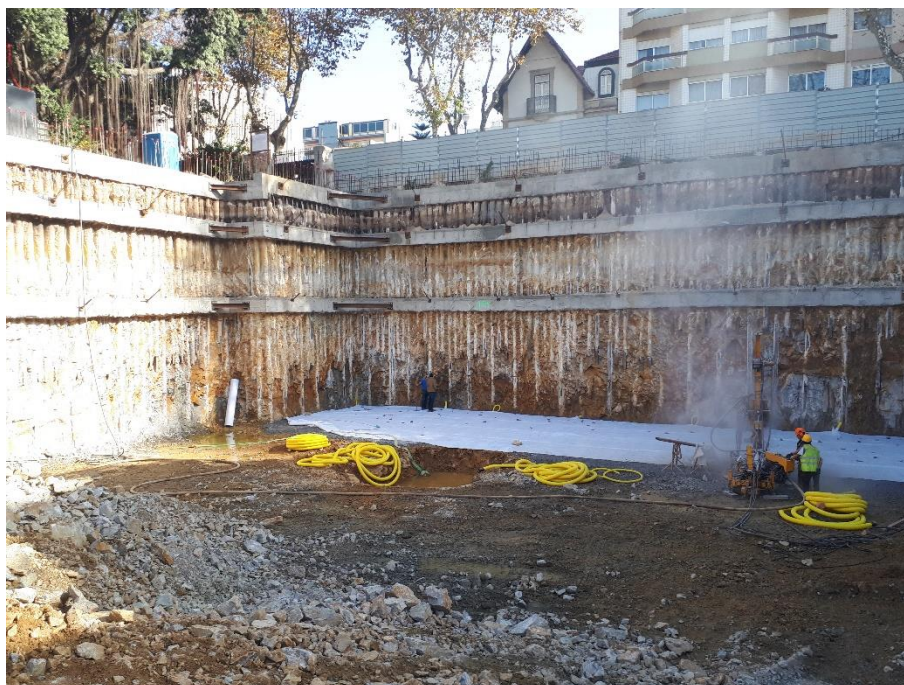
Figura 8 – Vista parcial da Obra no final da escavação
