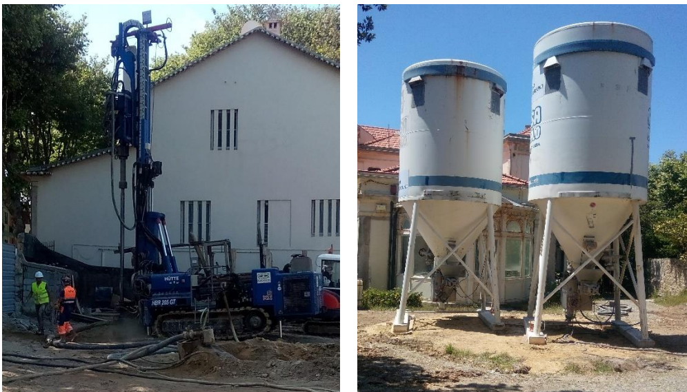
Figura 6 – Fotografias do equipamento utilizado na execução das microestacas (fotografias dos autores)
