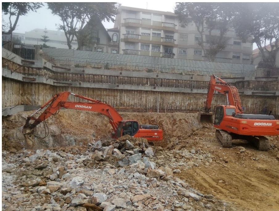
Figura 7 – Fotografia da obra antes da aplicação do terceiro nível de escoramento e pregagens (fotografia dos autores)
