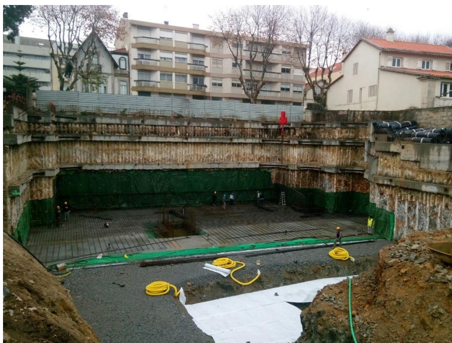
Figura 9 – Vista da Obra no início da construção da estrutura definitiva
