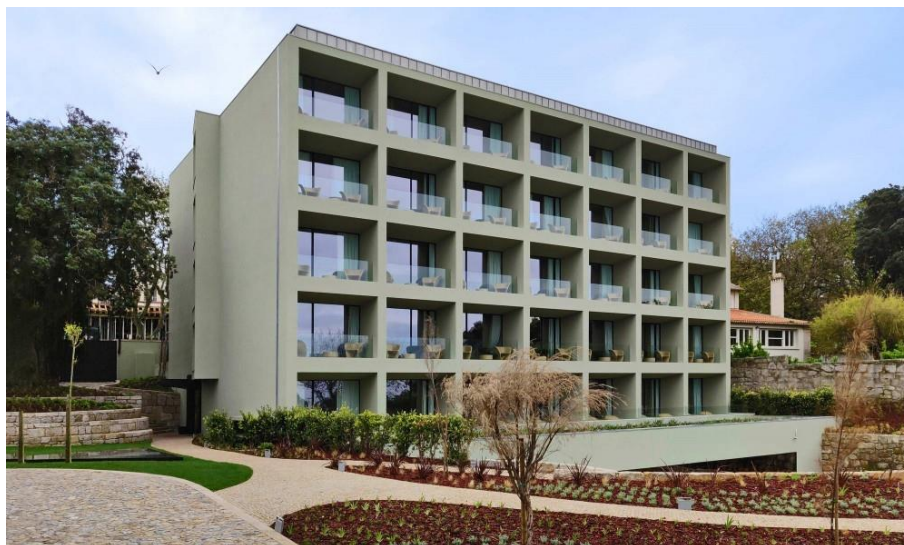
Figura 1 – Vista do Edifício Construído
