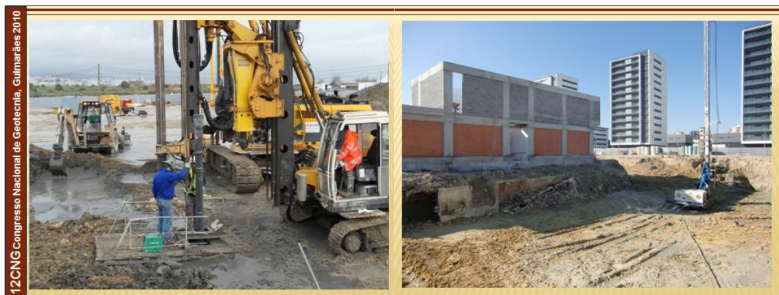
Figura 12 – Execução das Microestacas cravadas e das Colunas de Jet Grouting
