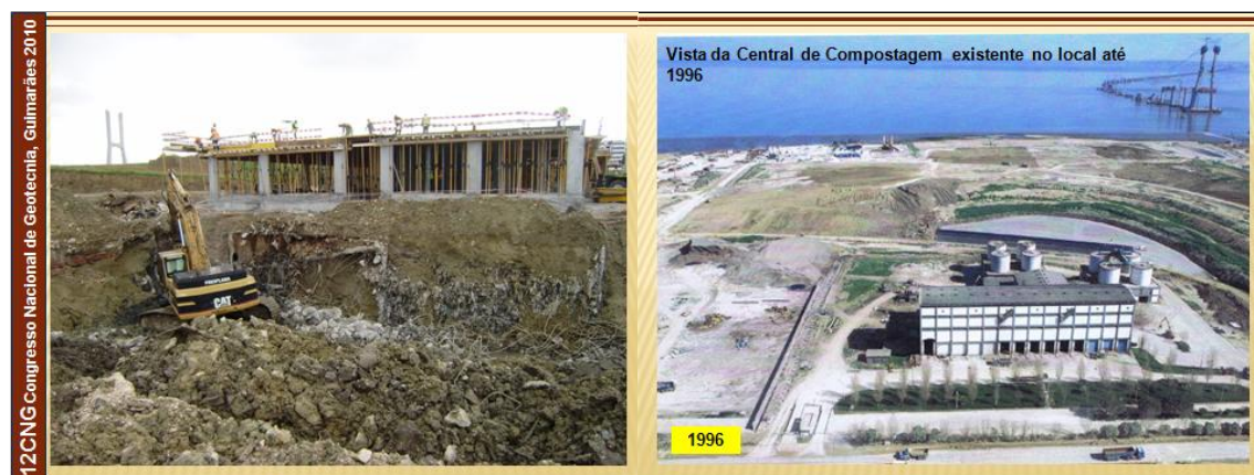
Figura 10 – Escavação e Demolição de Estruturas Enterradas e vista da Central de Compostagem - 1996
