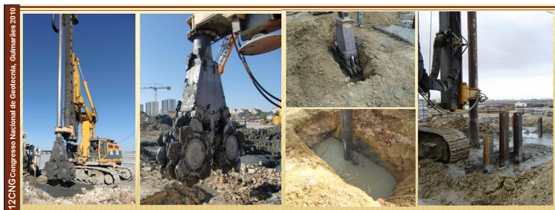
Figura 6 – Equipamento e execução de Painéis de Solo – Cimento através da Tecnologia de CSM
