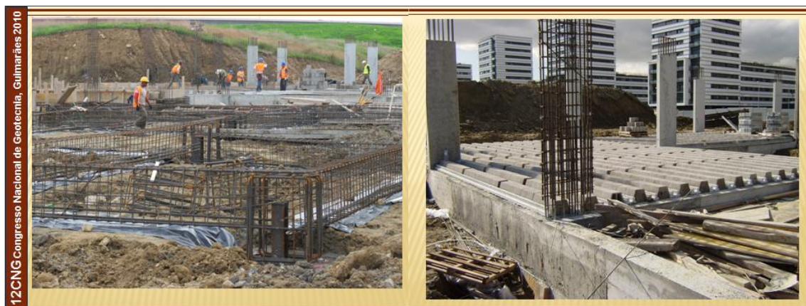
Figura 4 – Execução dos Maciços e Vigas de Fundação e da Laje do Piso Térreo
