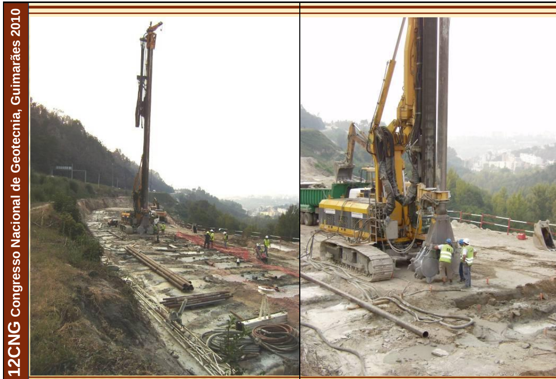
Figura 3 – Vistas da execução dos painéis de solo-cimento na fundação do muro M4B
