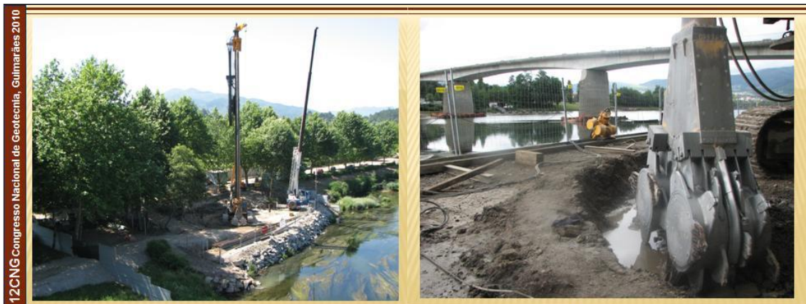
Figura 4 – Vista da execução dos painéis de CSM no poço da margem esquerda
