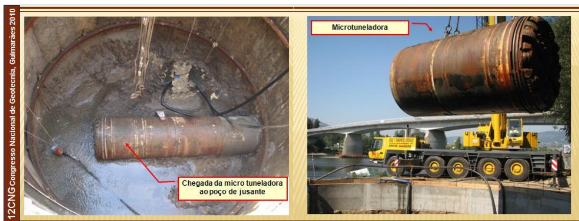
Figura 16 – Vista da chegada e da remoção da microtuneladora do interior do poço de jusante (margem direita)
