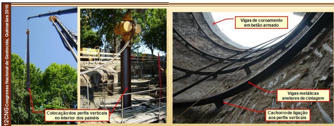
Figura 5 – Vista da cravação dos perfis metálicos no interior dos painéis e do sistema de cintagem dos mesmos painéis
