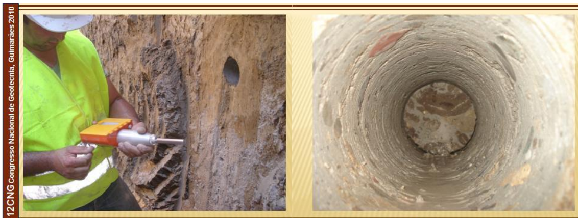
Figura 13 – Vista da execução das carotes nos painéis de solo – cimento e do interior do furo de uma carote
