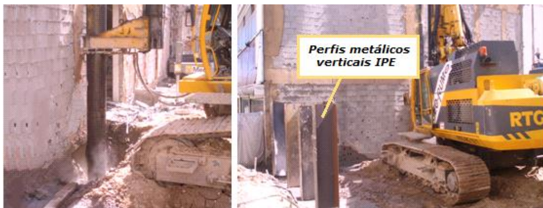
Figura 10 - Execução de um Painel de CSM (à esquerda) e Perfis Verticais IPE (à direita)
