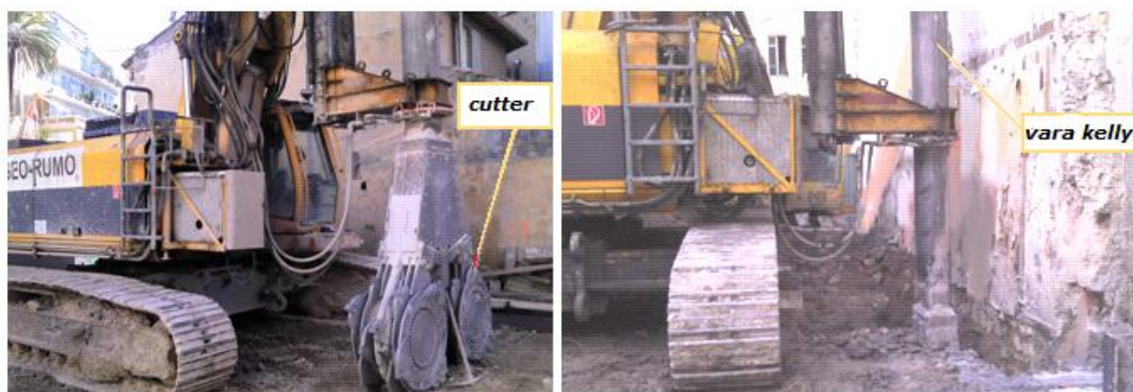
Figura 9 - Equipamento, Ferramenta de Corte (à esquerda) e Execução de um Painel de CSM (à direita)
