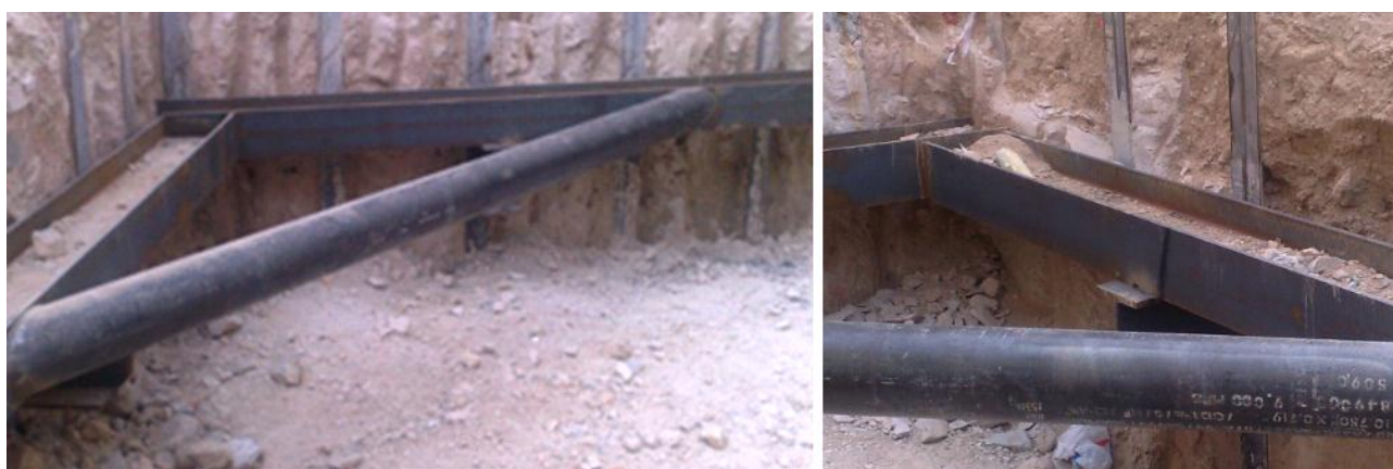
Figura 11 - Pormenor da Viga de Distribuição Metálica (directamente ligada aos perfis verticais da estrutura de contenção)
