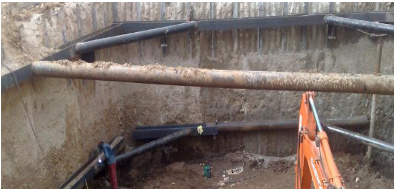
Figura 12 – Vista parcial da Obra durante a Fase de Escavação
