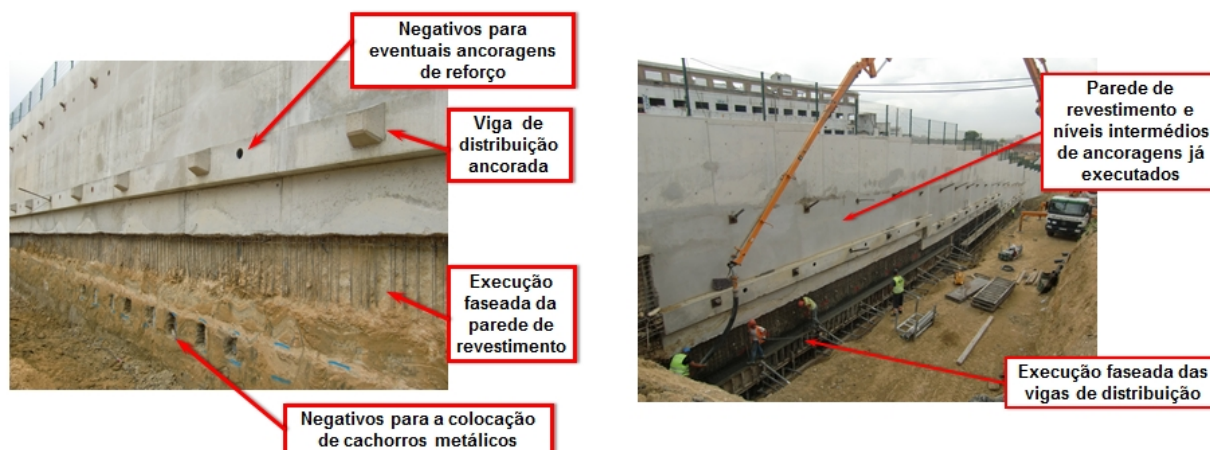
Figura 5 – Fase intermédia da execução das estruturas de suporte.
