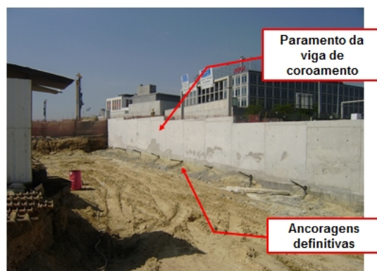
Figura 10 – Fase 2 do faseamento construtivo do Muro M3A.
