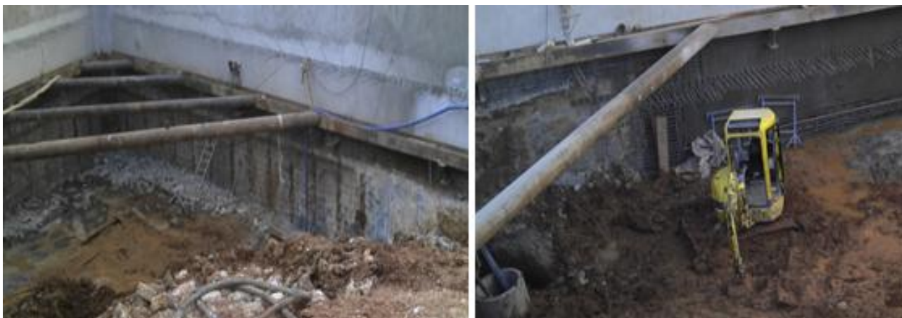
Figura 13 – Vistas da obra onde se podem observar as vigas de distribuição e as escoras metálicas
