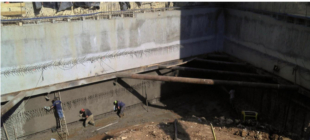
Figura 8 – Aspecto parcial da estrutura de contenção após a execução das vigas de distribuição metálicas, das escoras metálicas e da parede em betão projectado
