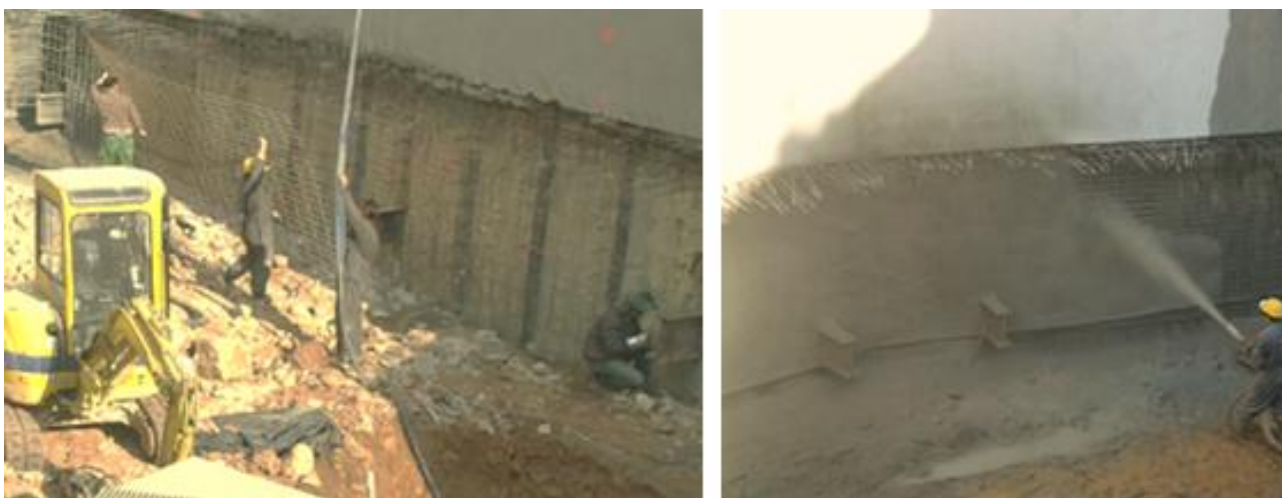
Figura 14 – Colocação da armadura (à esquerda) e projecção de betão para revestimento da parede de CSM (à direita)
