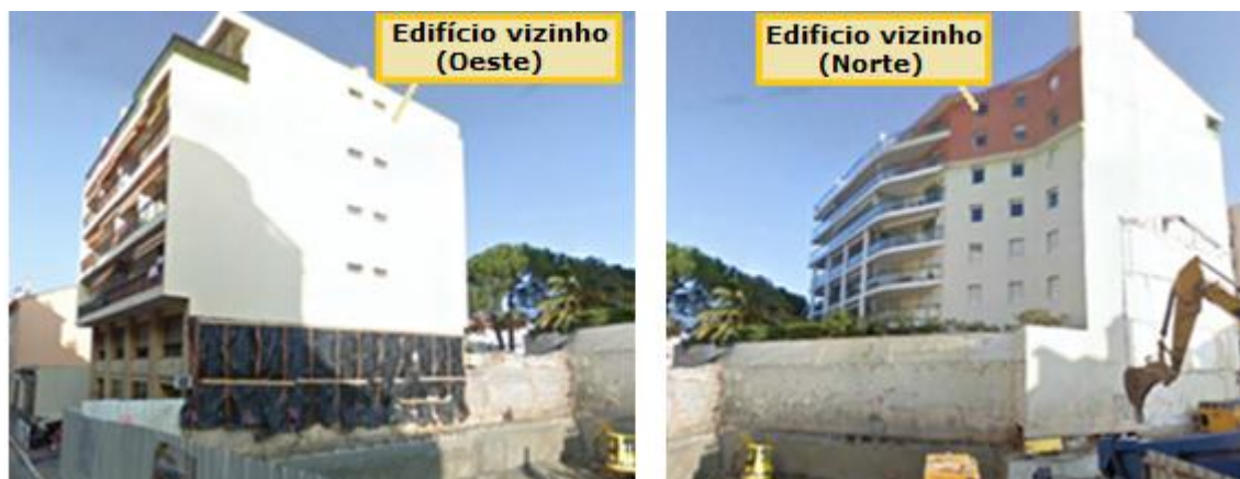
Figura 4 – Edifícios que confrontam directamente com o recinto de escavação no alçado oeste (à esquerda) e no alçado norte (à direita)
