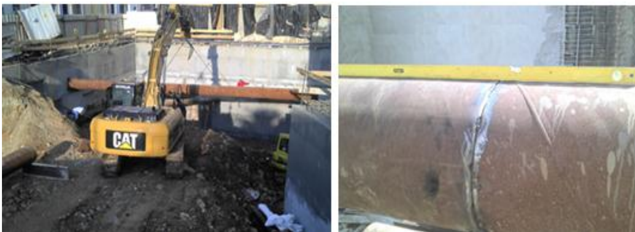
Figura 15 – Vista parcial da obra após durante a sua execução (à esquerda) e pormenor de uma escora metálica tubular (à direita).
