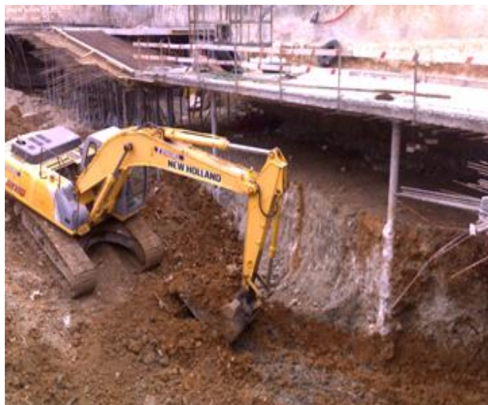
Figura 11 – Fotografia da obra durante a fase de escavação após a execução do 1º nível de travamento
