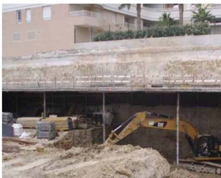
Figura 12 – Fotografia da obra durante a escavação abaixo do 1º nível de travamento
