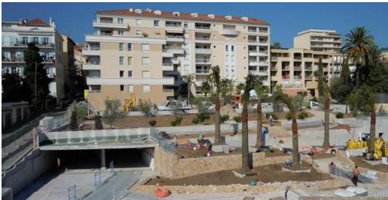
Figura 15 – Aspecto geral na fase final da obra
