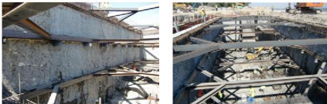
Figura 7 – Vistas dos vários níveis de travamento e da parede de contenção de solo-cimento.
