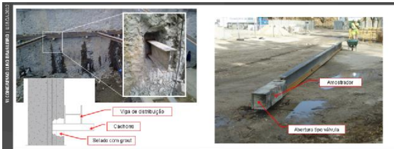
Figura 6 – Ligação das vigas de distribuição à contenção. Amostrador para recolha de amostras frescas dos painéis.
