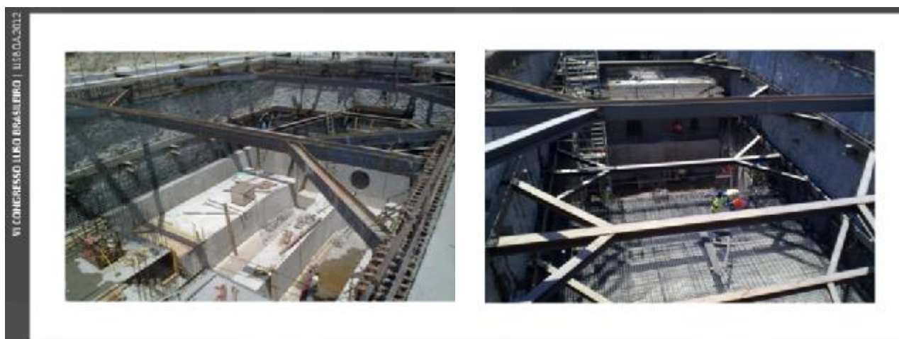
Figura 11 – Vistas do interior da contenção e seus travamentos. Execução da laje de fundo e estrutura interior.
