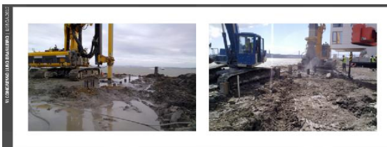
Figura 4 – Execução dos painéis de CSM. Topo dos perfis metálicos introduzidos no interior dos painéis.
