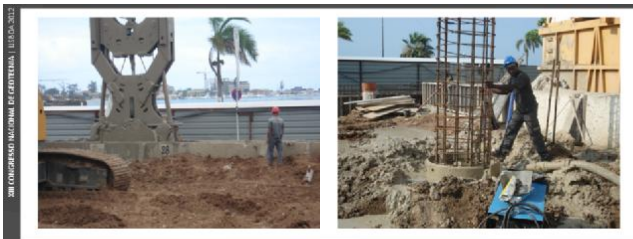
Figura 4 – Execução dos painéis de parede moldada. Execução das estacas moldadas.
