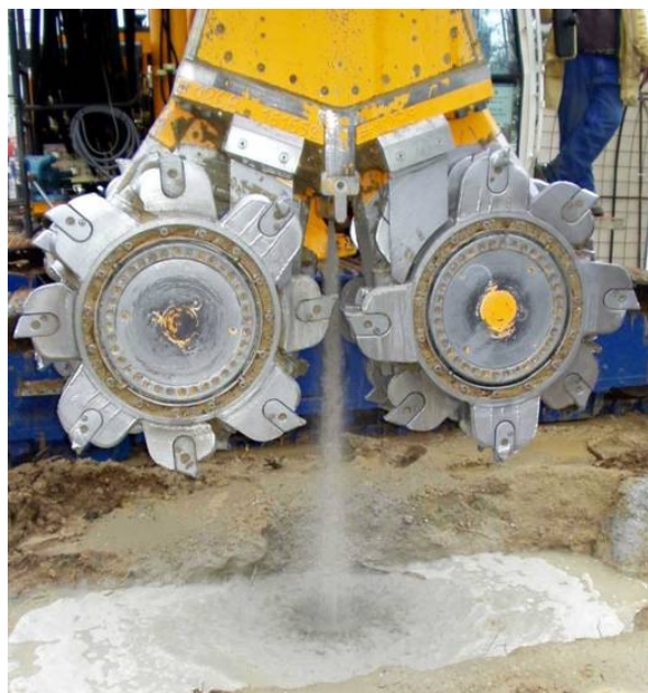
Figura 2 – Corte e mistura em descendente.
