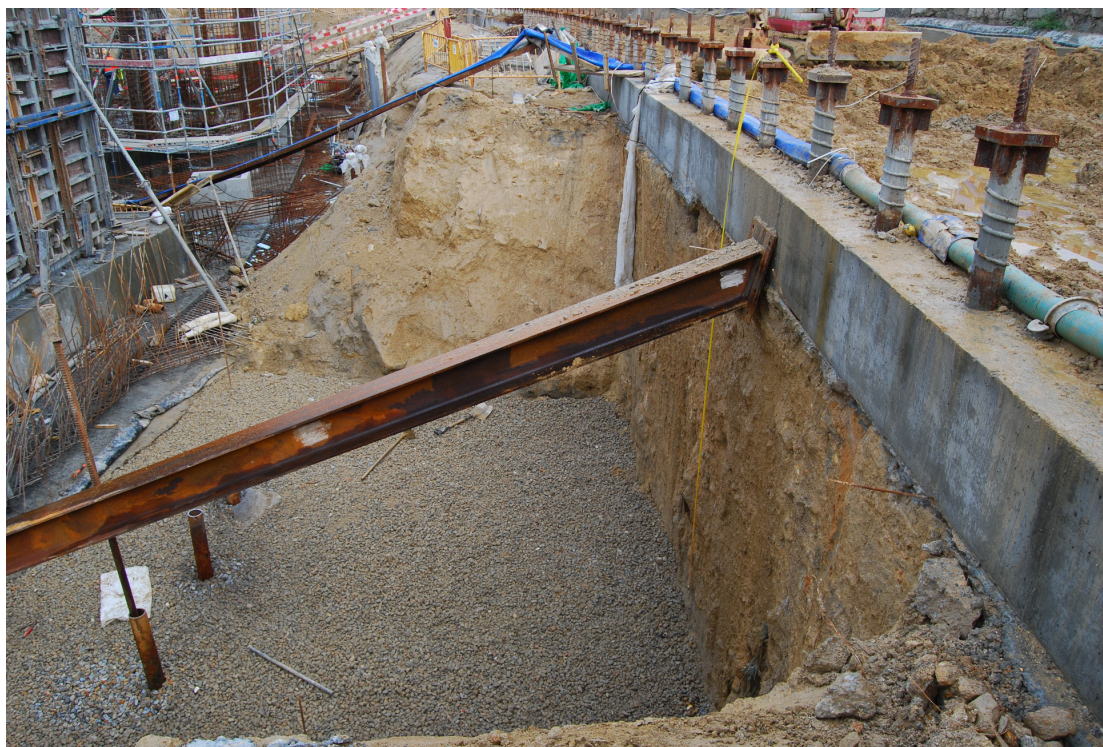
Figura 18 – Aspeto final da cortina de contenção periférica em CSM executada na zona 2
