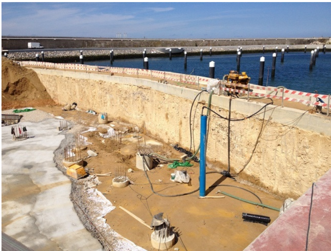
Figura 3 – Aspeto final da cortina de contenção periférica em CSM executada na zona 1
