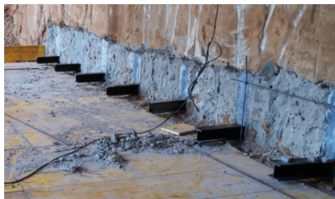
Figura 5. Fotografia dos perfis HEA de ligação da laje
