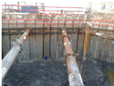
Figura 15. Fotografia da obra antes da aplicação do segundo nível de escoramento (Geo-Rumo)
