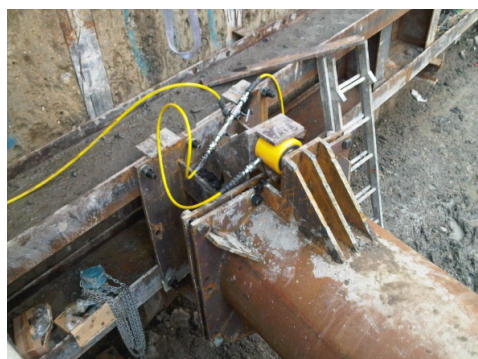
Figura 16. Fotografia do sistema de aplicação de pré-esforço (gentileza da Geo-Rumo)
