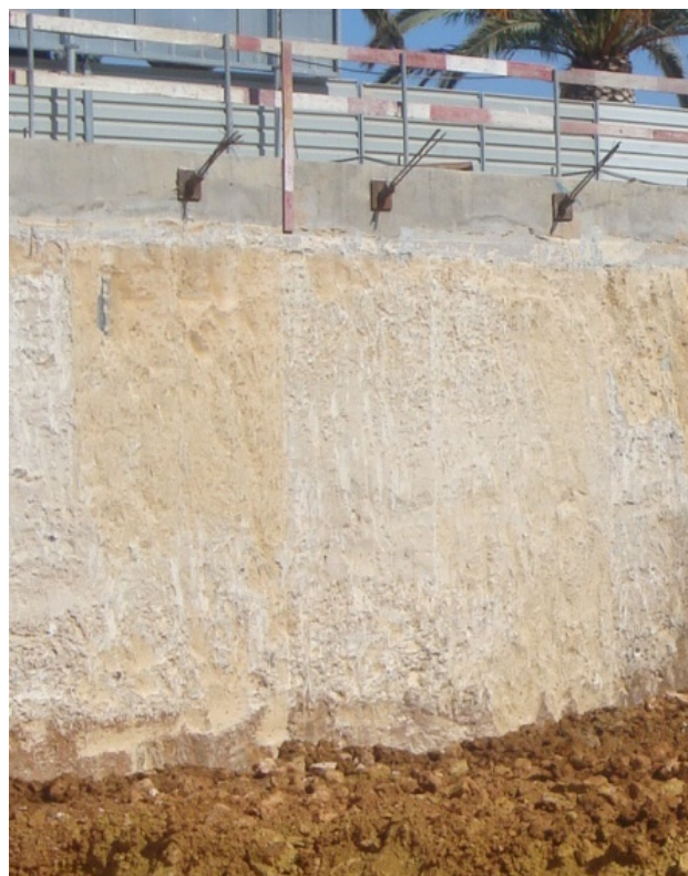
Figura 4. Vista da parede de CSM
