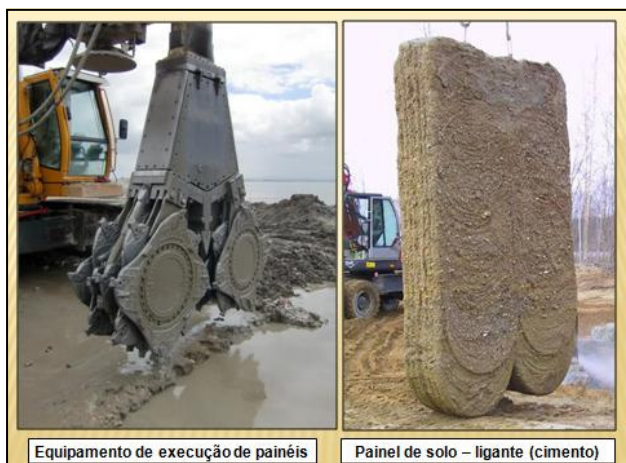
Figura 1. Vista do equipamento de execução e de um painel de solo-ligante através da tecnologia de CSM
