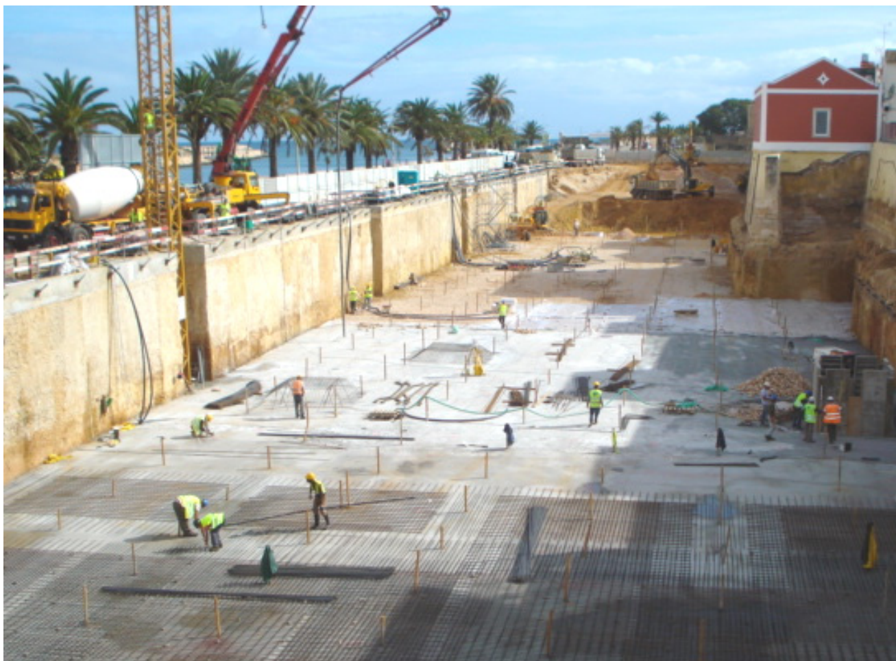
Figura 3. Vista geral da obra depois de concluída a escavação
