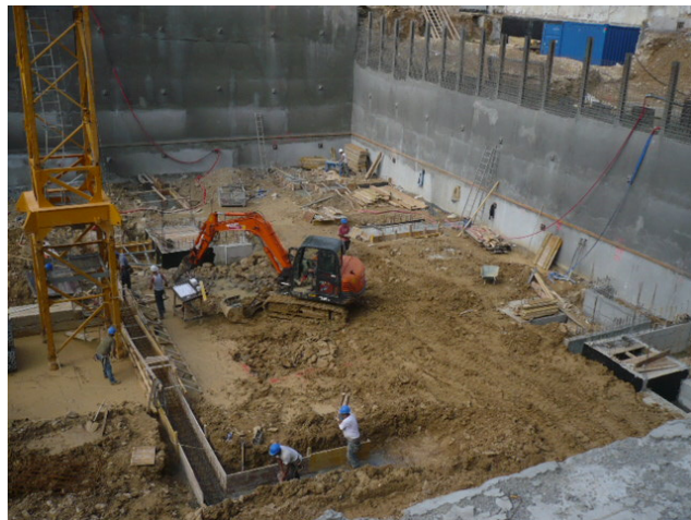
Vue général du chantier
