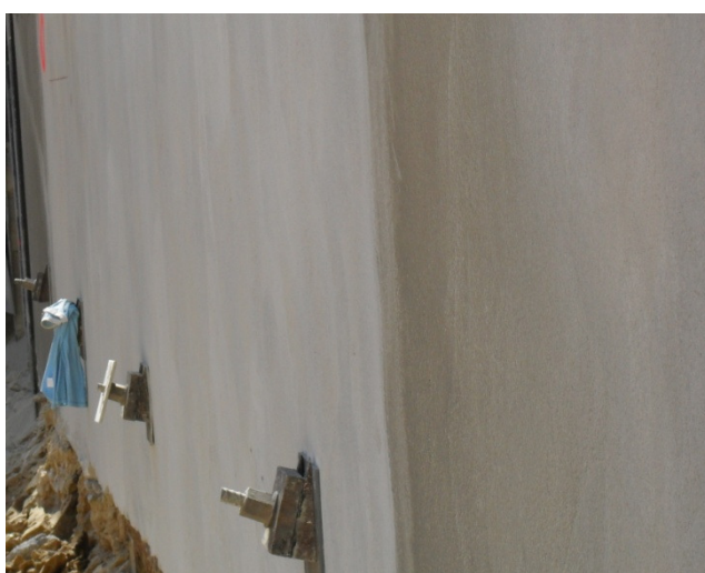
Détail de la paroi berlinoise et tirants d'ancrage
