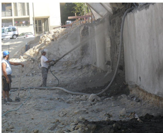
Travaux de projection de béton
