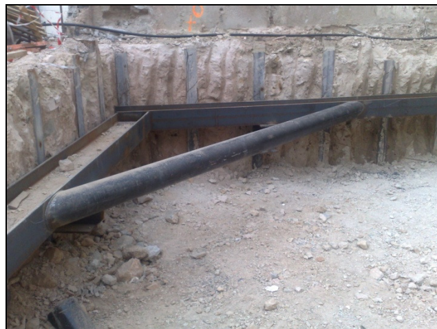
Détail du 1 er niveau de butonnage provisoire
