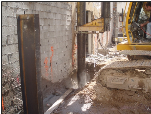
Travaux de foration des panneaux CSM
