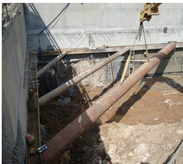
Butonnage de la paroi
