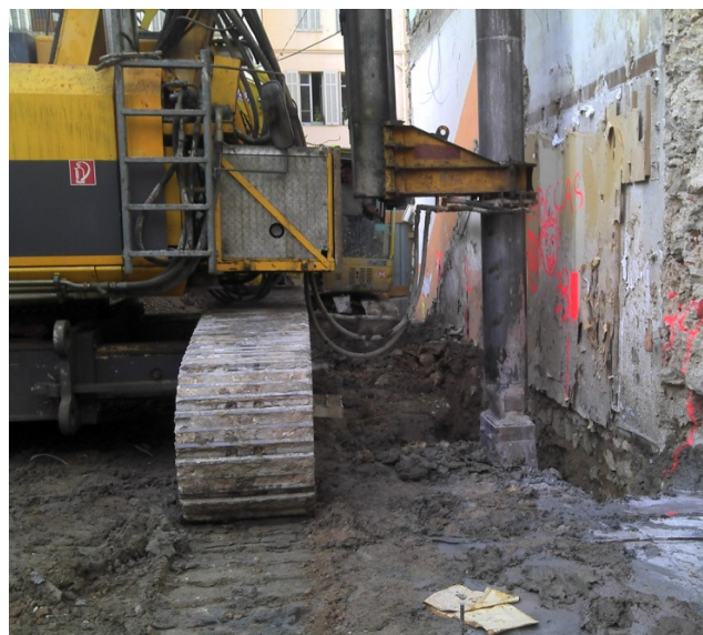
Travaux de perforation
