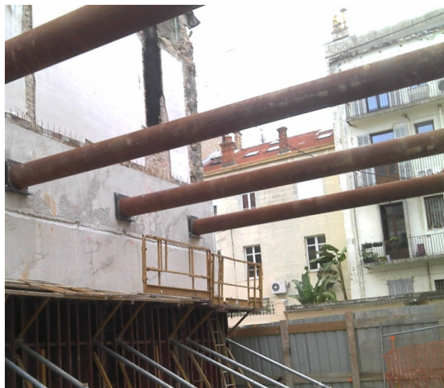
Confortement de façades avoisinantes
