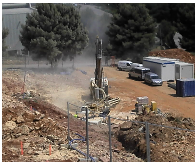
Travaux de foration des micropieux
