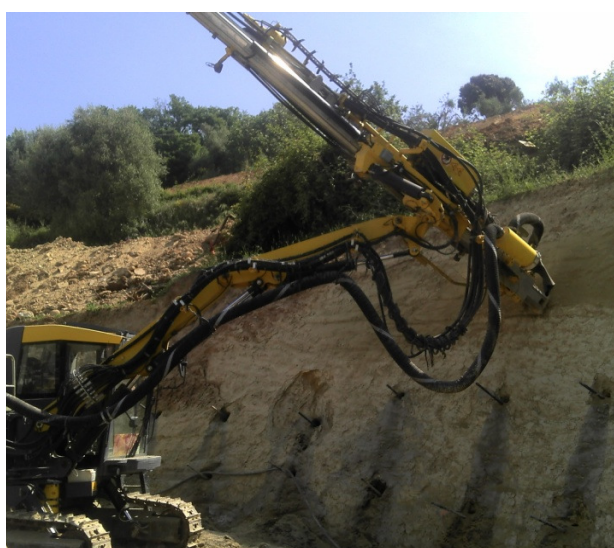
Travaux de perforation des clous
