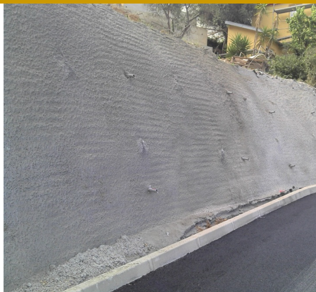
Paroi clouée en béton projeté
