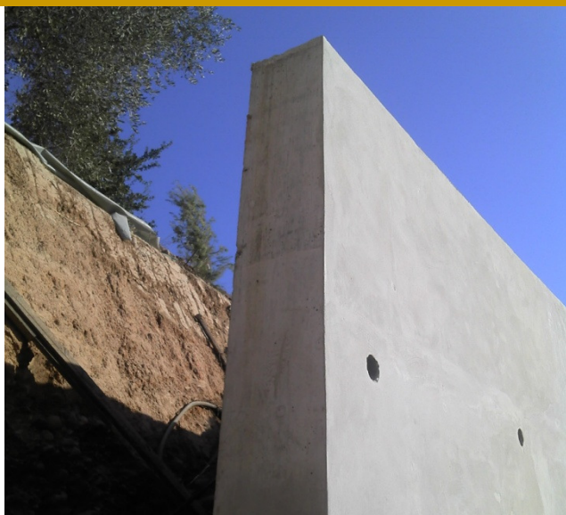
Détail du mur gravité en béton armée
