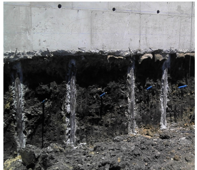
Détail de la paroi microberlinoise
