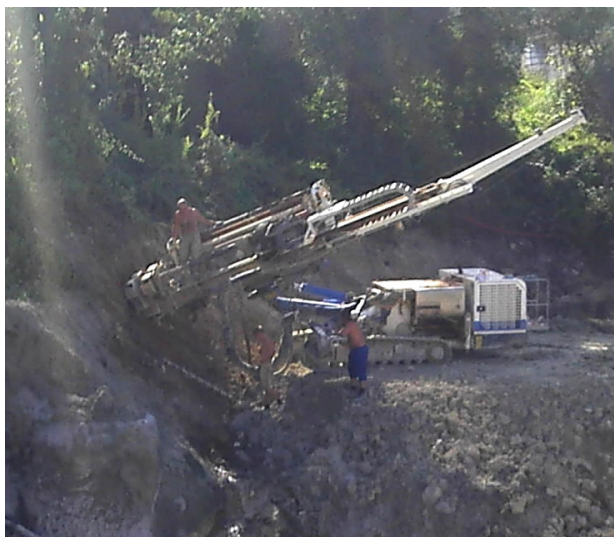
Travaux de foration des clous
