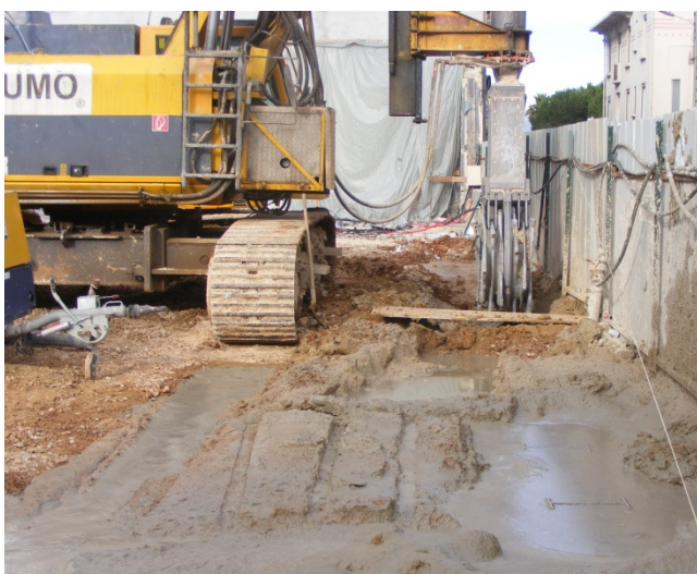
Travaux de perforation
