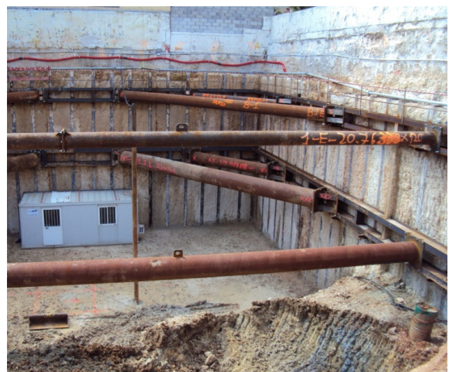
Travaux de terrassement et butonnage
