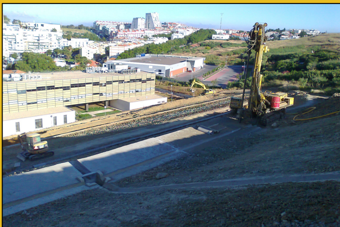
Figura 3 – Execução dos Inclinómetros
