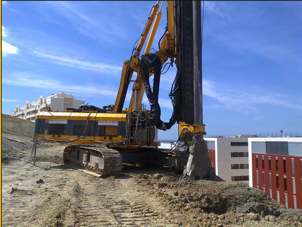
Figura 2 – Execução da Cortina e dos Contrafortes em CSM
