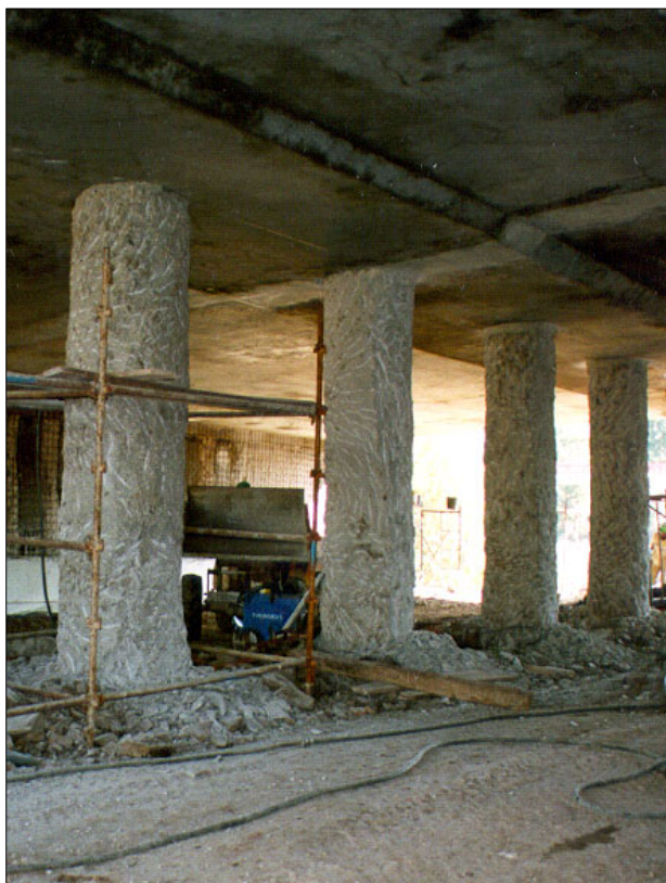
Estacas-Pilar (fase de execução)/Pile-Pillars (in execution)
