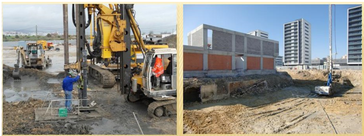
Figura 6 – Execução das microestacas cravadas e das colunas de jet-grouting
