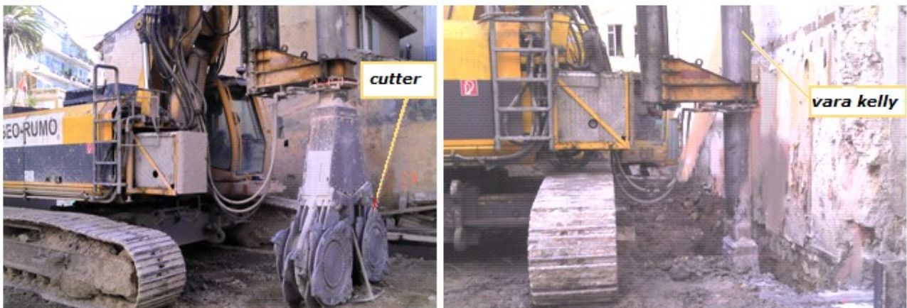
Figura 4 – Equipamento e ferramenta de corte (à esquerda) e execução de um painel de CSM (à direita)
