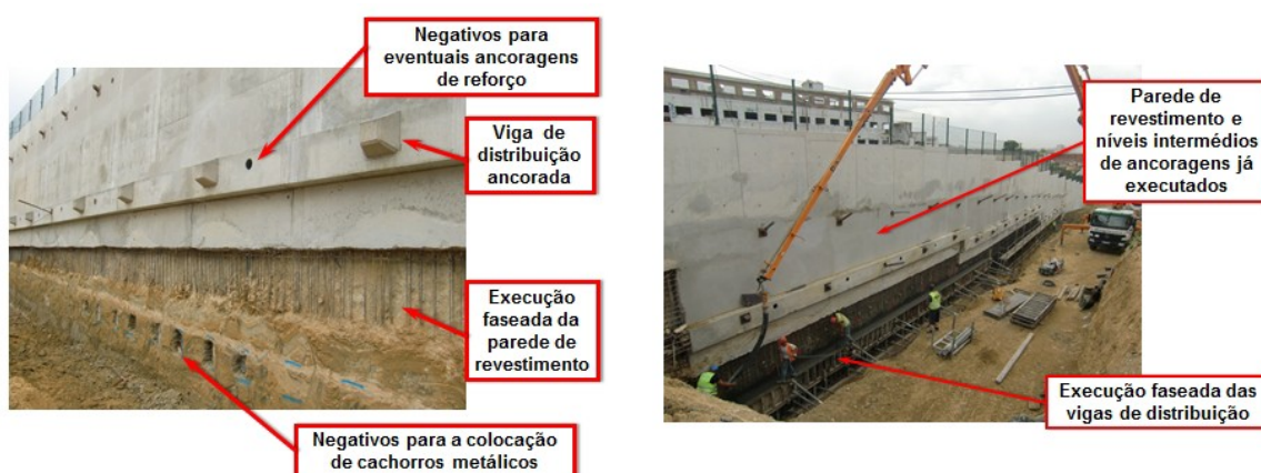
Figura 2 – Fase intermédia da execução das estruturas de suporte
