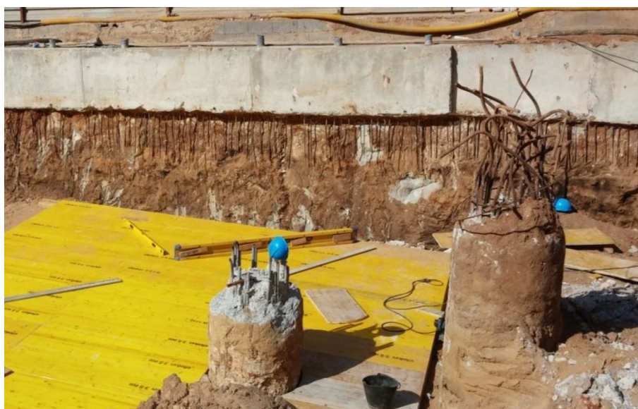
Figura 2 – Fotografia do início da execução da laje de cobertura
