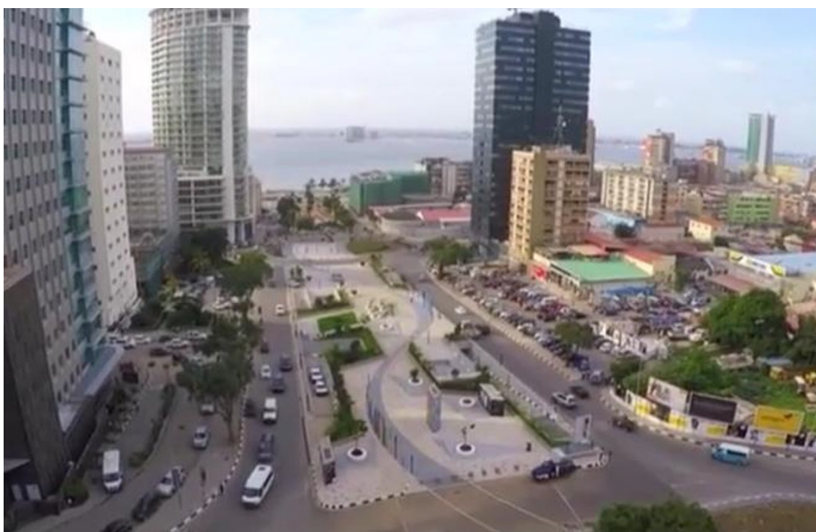
Figura 4 – Aspeto final da obra
