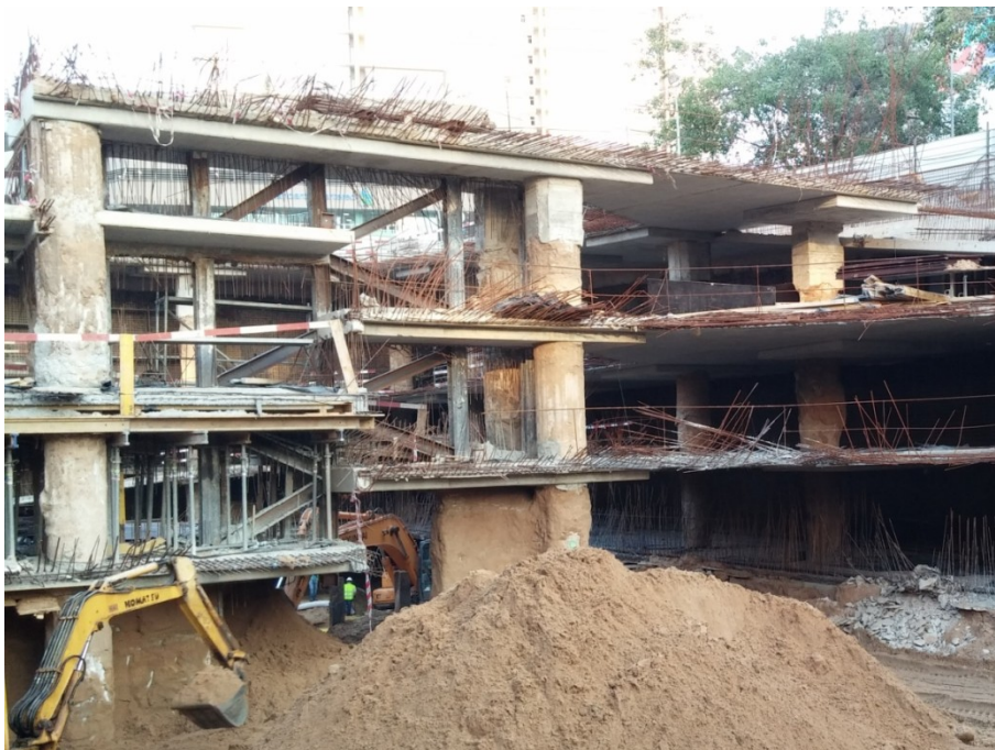
Figura 3 – Vista parcial da obra durante a fase de escavação
