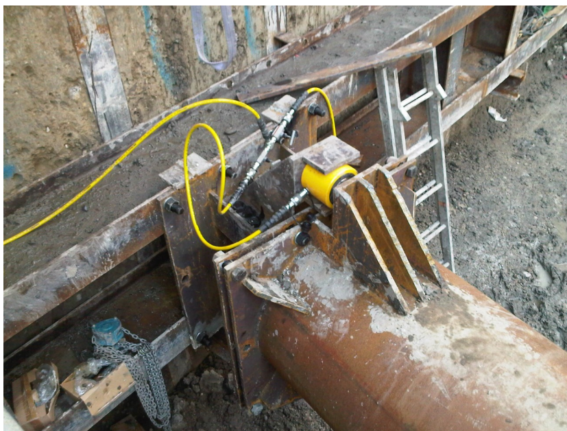
Figura 4 – Fotografia do sistema de aplicação de pré-esforço
