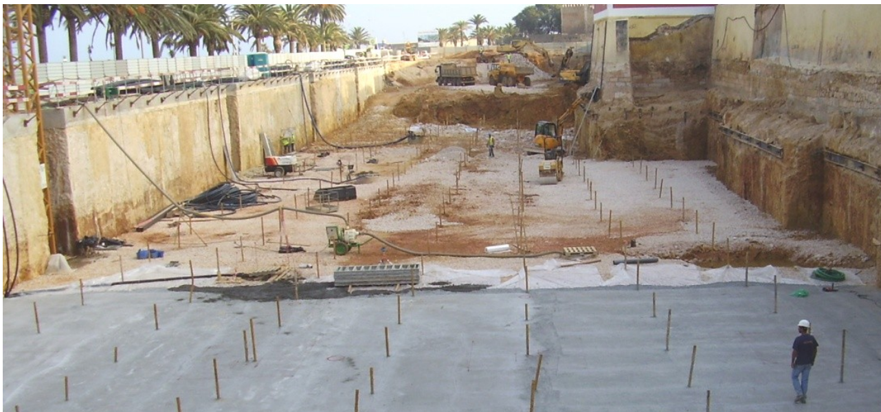
Figura 4 – Regularização do fundo de escavação e aplicação do betão de limpeza
