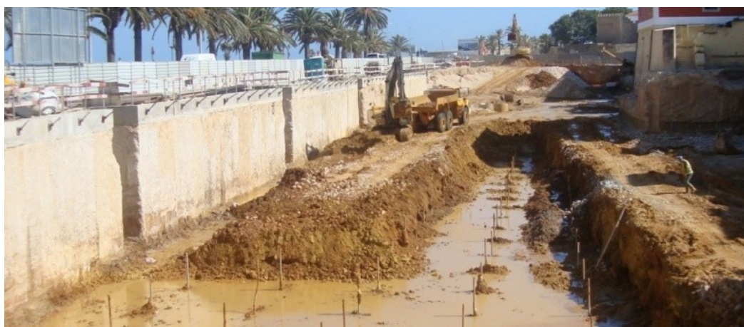
Figura 2 – Vista geral da escavação
