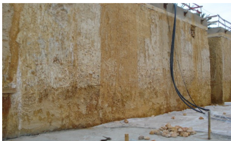
Figura 3 – Pormenor da face dos painéis CSM
