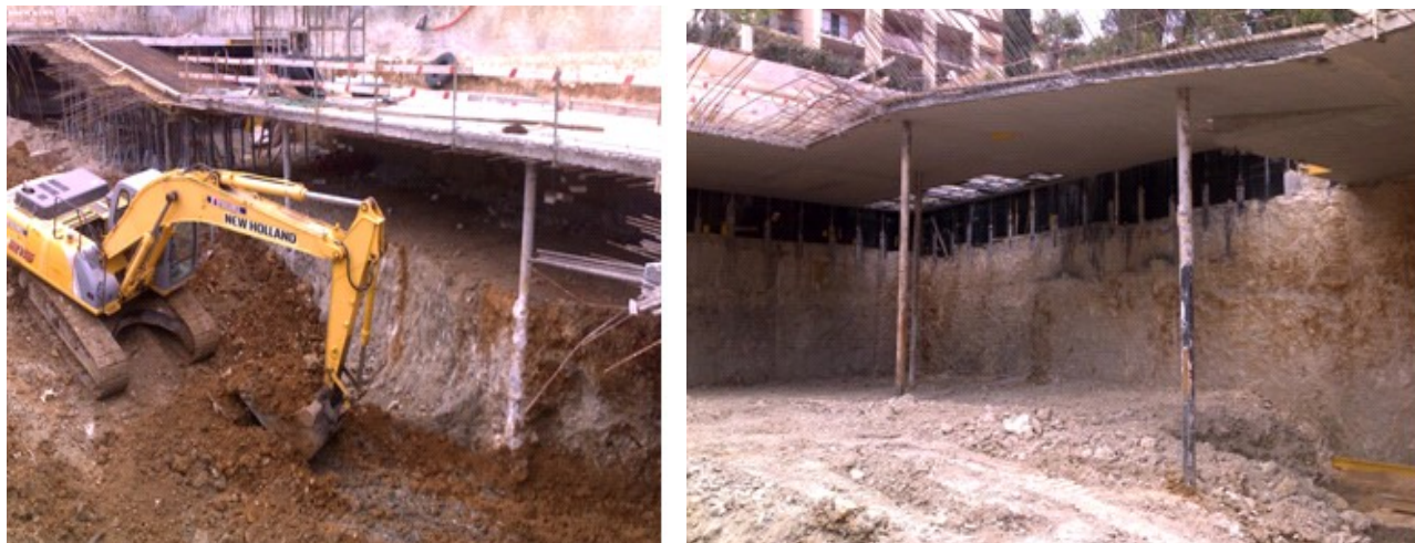
Figura 4 – Fotografias da obra durante a fase de escavação após a execução do 1º nível de travamento
