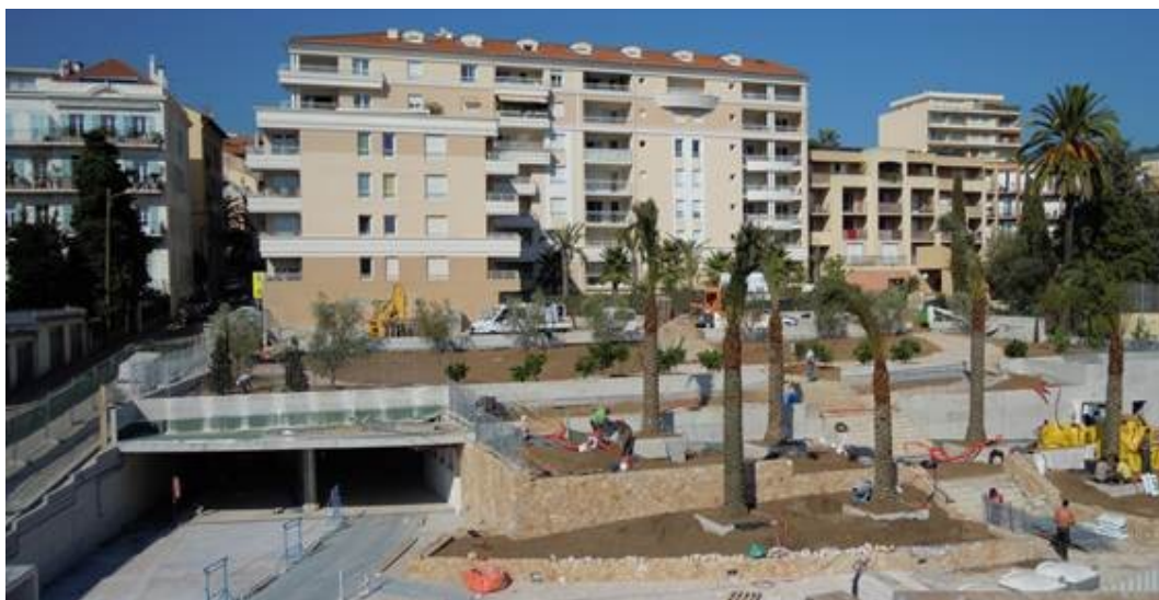
Figura 5 – Aspeto geral na fase final da obra
