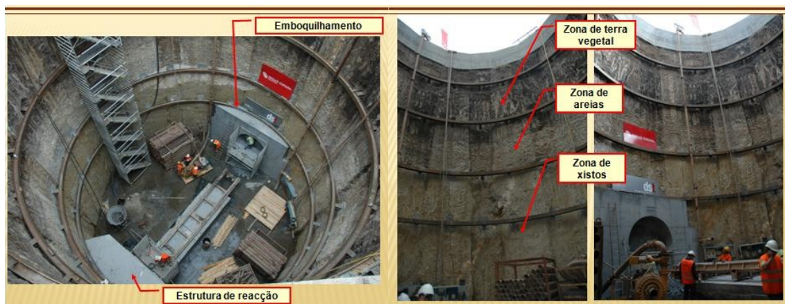
Figura 5 – Vistas do interior do poço da margem direita após a conclusão dos trabalhos de escavação
