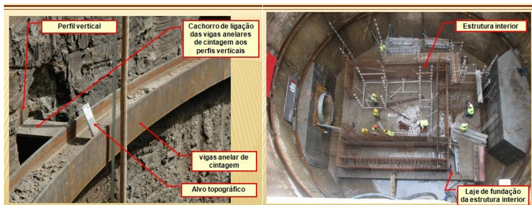
Figura 6 – Ligação das vigas de cintagem aos perfis verticais e vista da execução da estrutura interior
