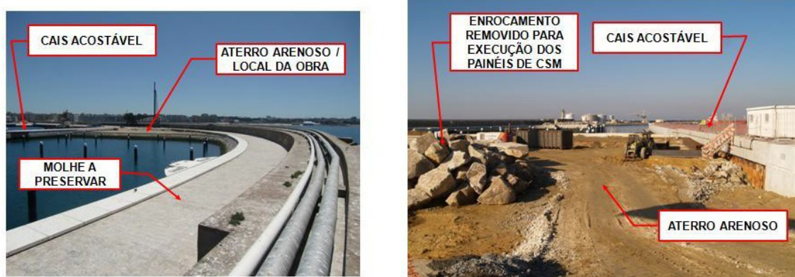
Figura 2 – Fotografia do local da obra
