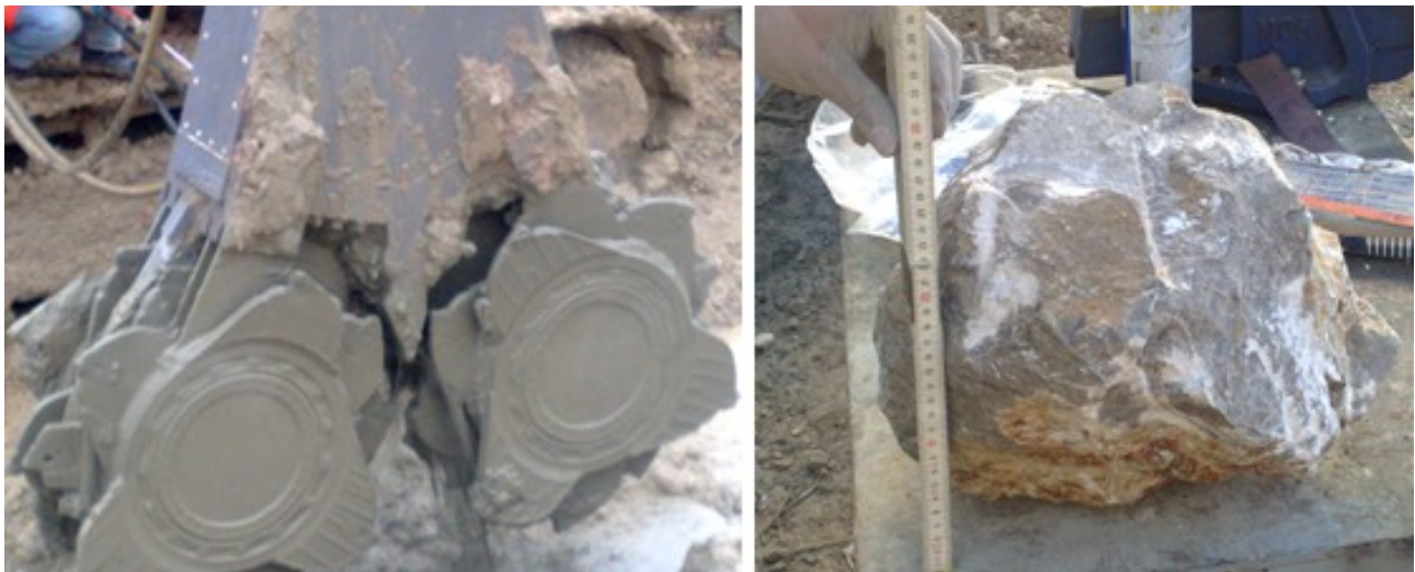
Figura 3 – Ferramenta de corte (à esquerda) e bloco rochoso recolhido durante a escavação (à direita)
