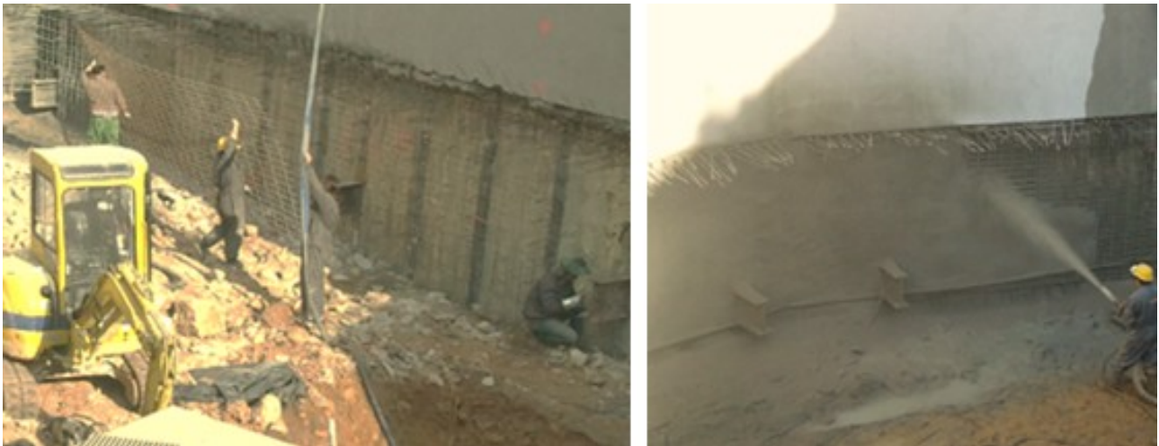
Figura 4 – Colocação da armadura (à esquerda) e projeção de betão para revestimento da parede de CSM (à direita)
