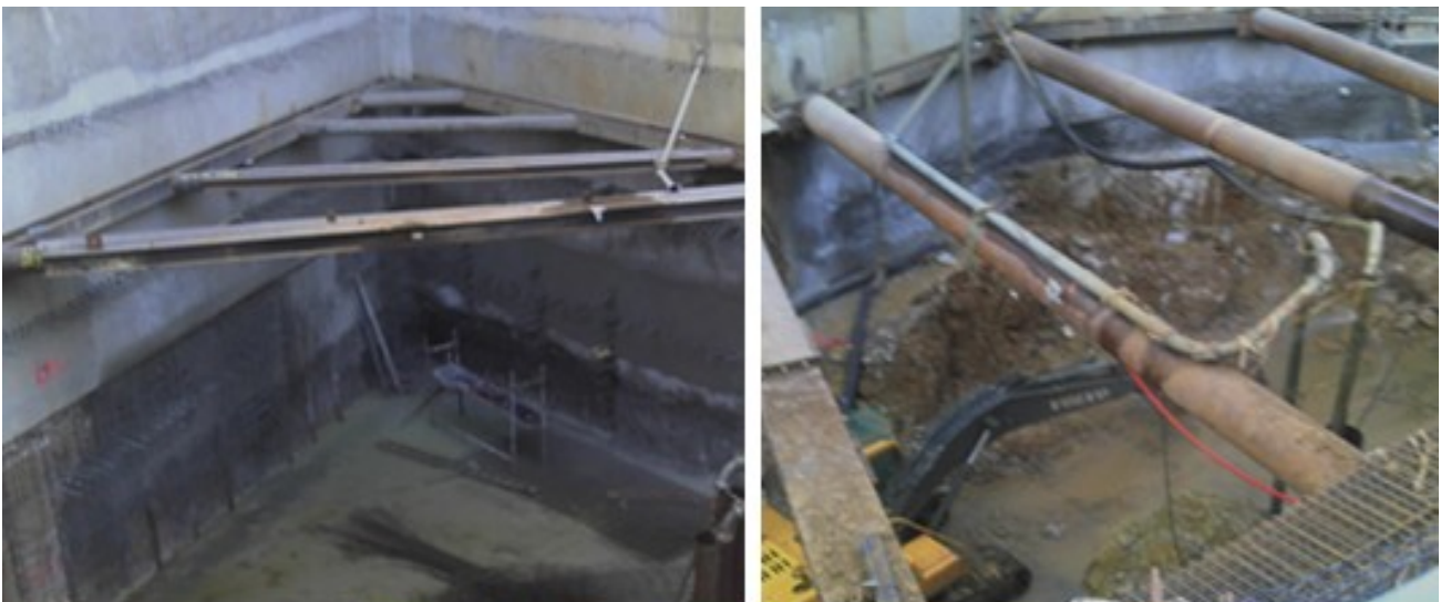
Figura 16 – Pormenor do escoramento metálico de canto (à esquerda) e vista parcial da obra durante a escavação abaixo do escoramento metálico (à direita).
