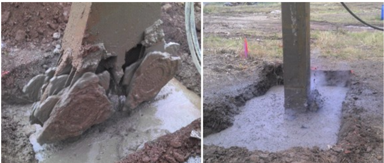
Figura 3 – Vistas do equipamento durante a execução de um painel de CSM
