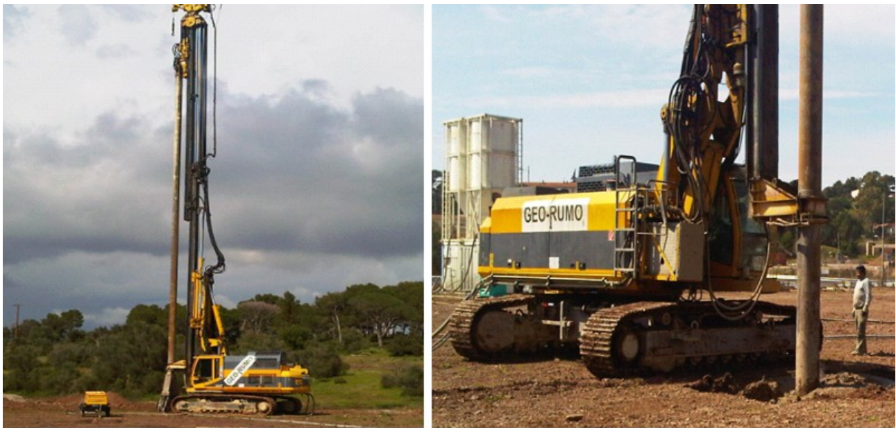
Figura 2 - Equipamento utilizado para a execução dos painéis de CSM
